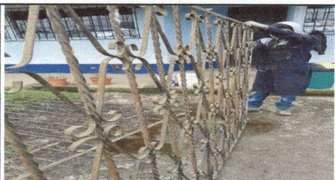
Foto 5: Cambio de balcones dañados y mantenimiento de balcones.
