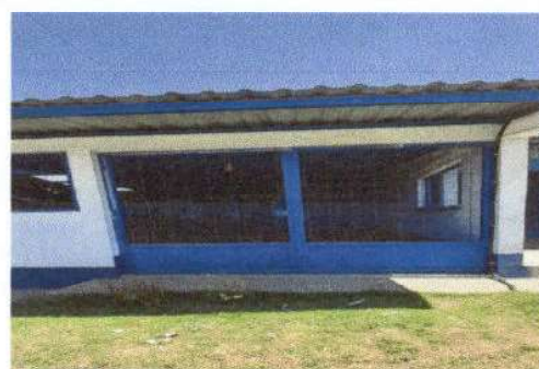
Foto 4: Remodelación de puerta del comedor, de dos hojas (Ancho 2.50, alto 2.18 mts).
