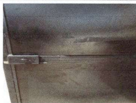
Foto 6: Cambio de chapas en mal estado y mantenimiento de puertas.
