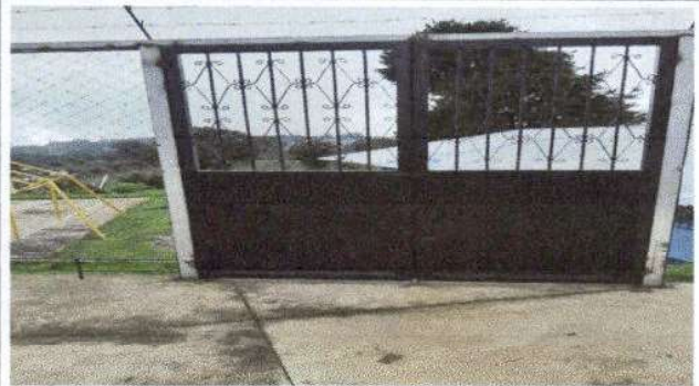
Foto 2: Instalación puerta de acceso a la cancha polideportiva
