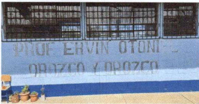
Foto1: Pintura de muros exteriores e interiores.
