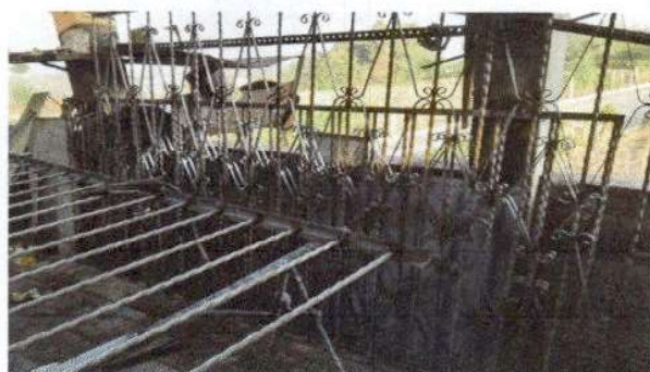
Foto1: Instalación de balcones nuevos.
