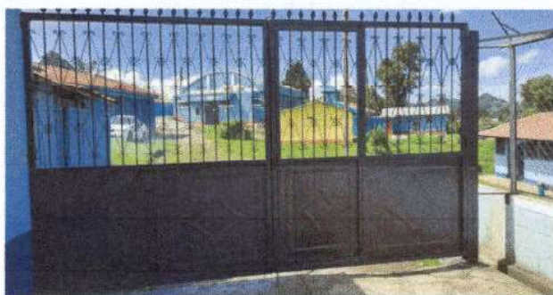
Foto 3: Instalación de portón principal y colocación de malla perimetral. (La malla se colocará sobre el muro)
