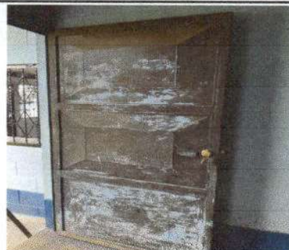
Foto 2: Cambio de puertas deterioradas
