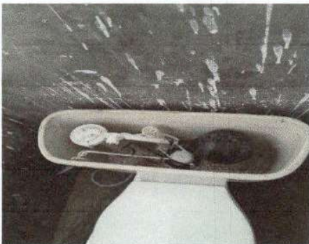
Foto 3: Instalación de inodoro
